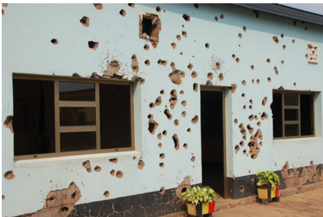
De plek in Kigali, Rwanda, waar in 1994 elf Belgische militairen werden aangevallen.
